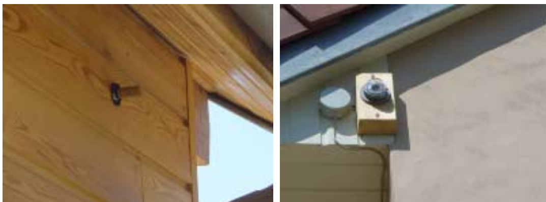
Figure 54 – Sonde extérieure et solarimètre
