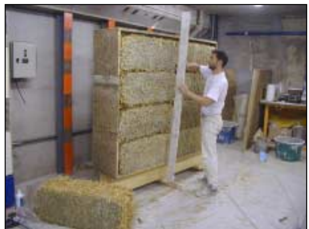
Figure 16 Vérification : la planéité est maintenant satisfaisante
