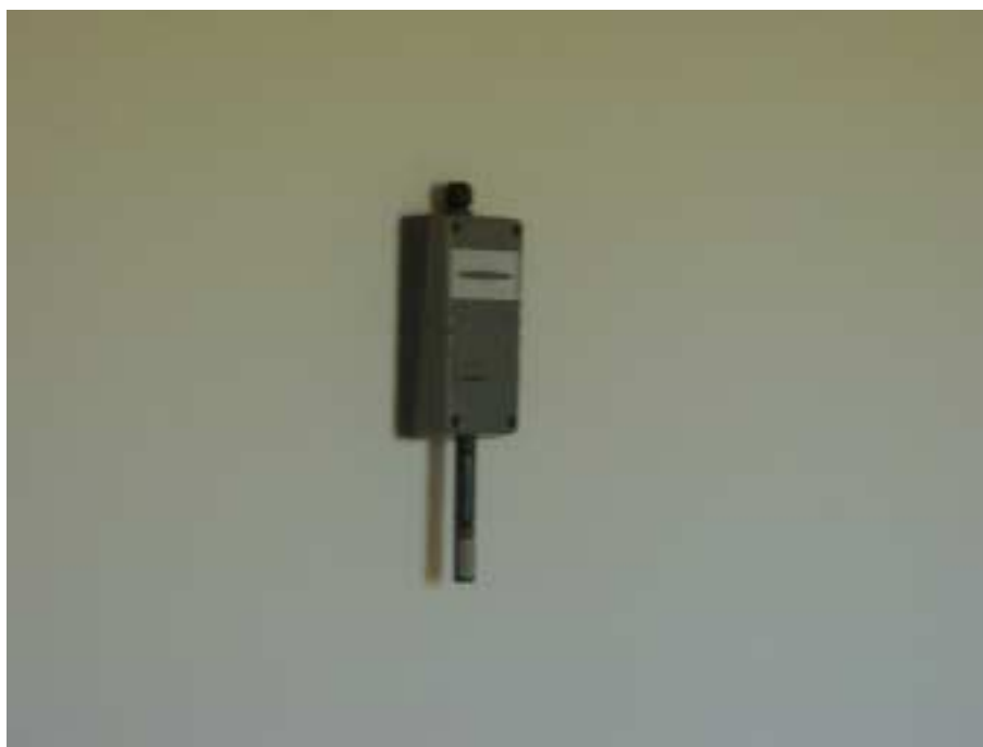
Figure 55 Sonde température – hygrométrie intérieure
