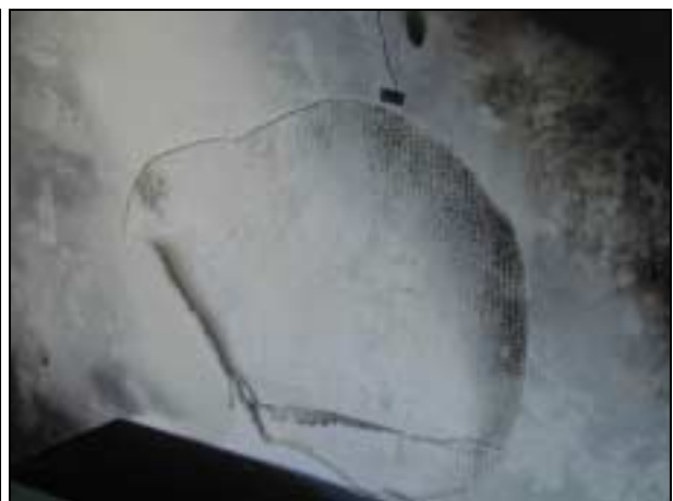
Figure 40 - La couche extérieure de l'enduit a cloqué, laissant voir la trace de l'armature
