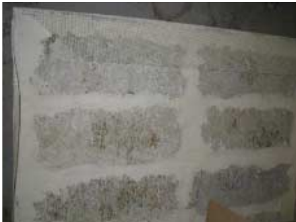
Figure 20 Mur paille avant enduits
