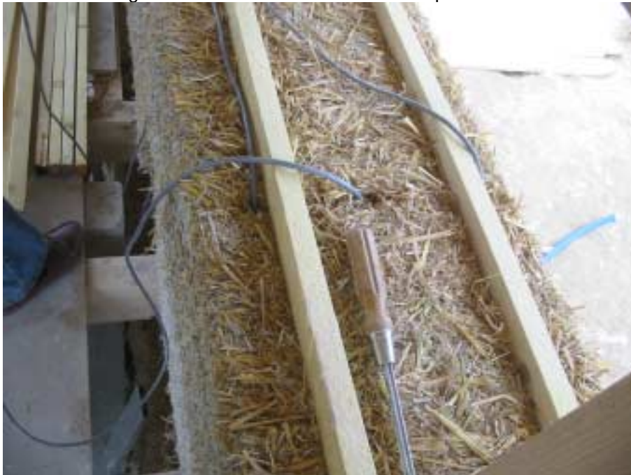
Figure 52 - Les trois sorties de sondes par section
