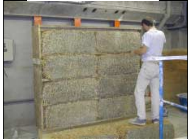
Figure 14 Rectification de la position des bottes
