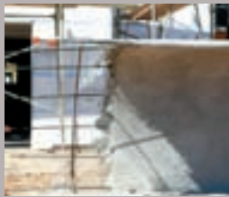
Partie centrale d'un mur en ciment mince avec armature et treillis métallique déployé.
