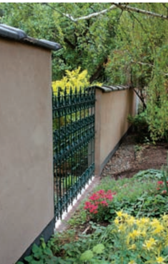
Grille en fer forgé incorporée dans le mur.
