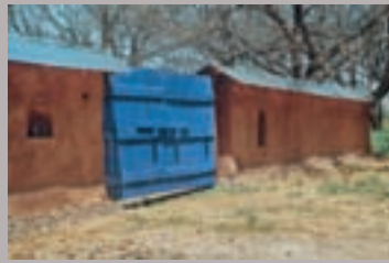
Mur en paille enduit de terre avec un toit en tôle ondulée. Patagonia, Arizona.
