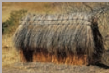
Bottes de paille à nu avec un toit de chaume fabriqué avec l'agave Nolina microcarpa , matériau de chaumage traditionnel dans le sud-est de l'Arizona et dans le nord du Mexique.
