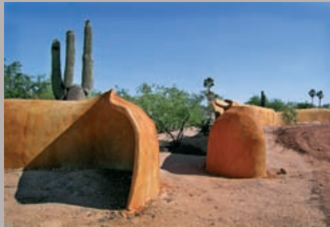
Mur courbe en ciment et treillis métallique, coloré avec du sulfate de fer, dans le lotissement communautaire « Stone Curves. » Tucson, Arizona.
